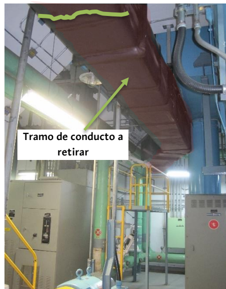
Figura 35: Detalle del conducto de ventilación a desmontar.
