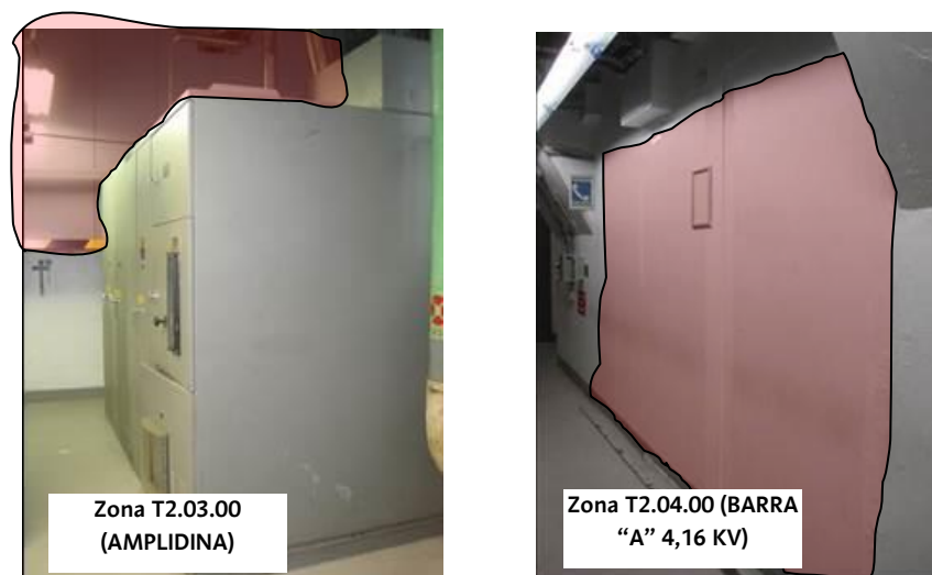
Figura 19: Muro anti explosión y cortafuegos.
