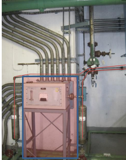
Figura 29: Detalle instalación del panel de hidrógeno H 2 del generador.
