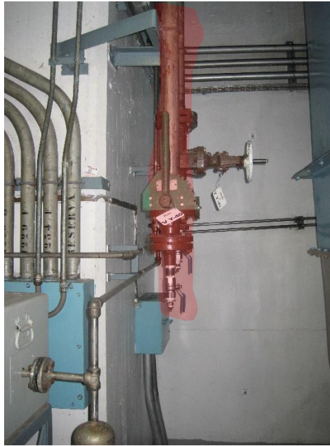
Figura 37: Detalle de la posición de las tuberías de refrigeración bobinas estator del generador
