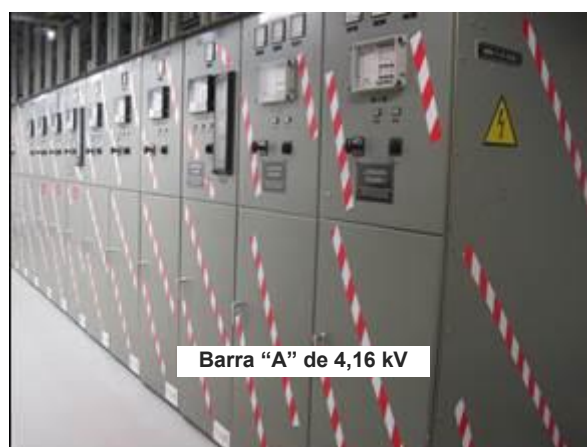
Figura 5: Frente y lado posterior de la barra “A” de 4,16 kV.
