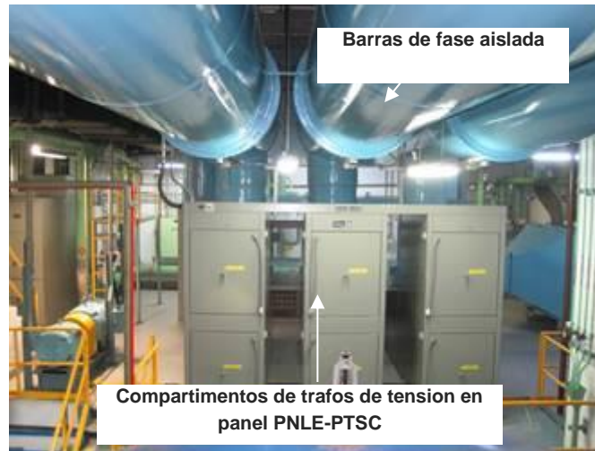
Figura 25: Compartimentos de trafos de tensión para protección y medida.
