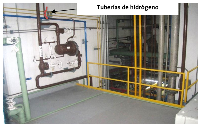
Figura 30: Tuberías amarillas de hidrógeno a cortar.
