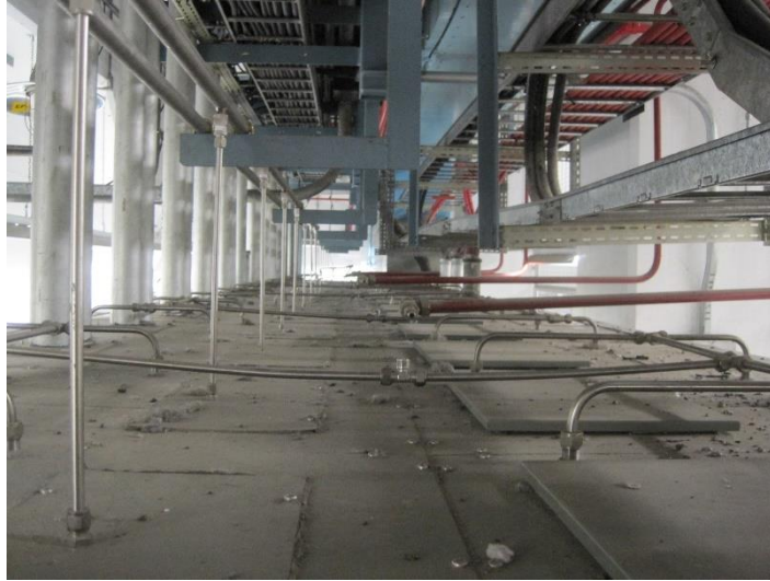
Figura 7: Sistema de extinción por gas Halón 1301.
