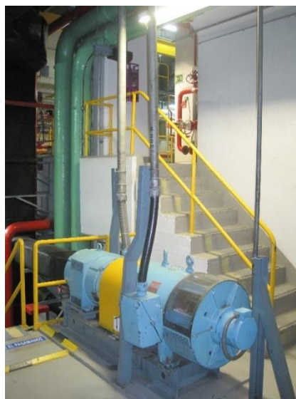
Figura 24: Detalle grupo motor generador de la amplidina GMG-E1-88.
