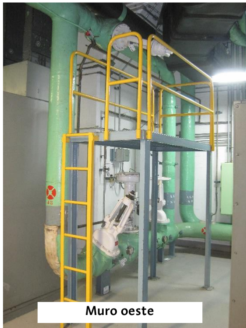
Figura 32: Ejemplo distribución de tuberías y válvulas del agua de servicios a desmontar.
