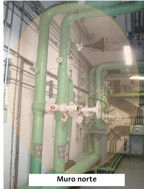
Figura 32: Ejemplo distribución de tuberías y válvulas del agua de servicios a desmontar.
