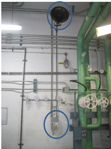
Figura 11: Sistema de megafonía en muro norte junto a la amplidina.
