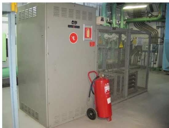
Figura 21: Transformador de PAT del neutro del generador y sus resistencias asociadas.
