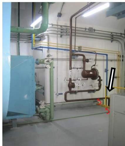
Figura 33: Tuberías de aguas de servicios indicadas en rojo a cortar.
