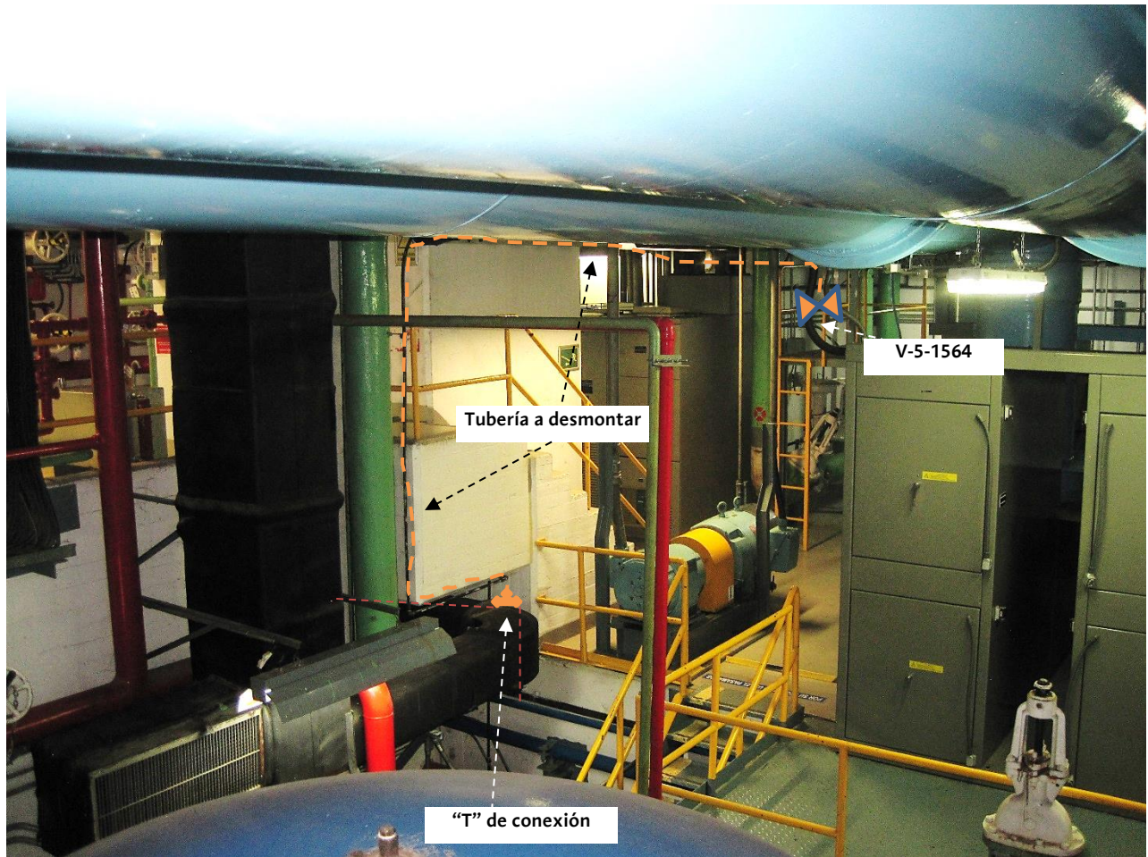
Figura 36: Detalle del recorrido de la tubería de aire de instrumentos a desmontar.
